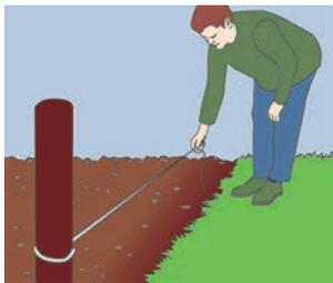
**Benötigtes Werkzeug:** Spaten, Hebelwerkzeug, Wasserwaage, Fugeisen, Hammer, Pinsel. Die Zaunrasse wird eingemessen. Legen Sie den Ausgangspunkt fest (z.B. Tor oder Eckpfosten).
