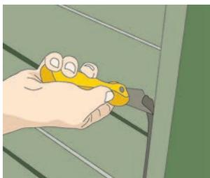
Um ein einheitliches Bild zu erhalten, müssen die Platten nunmehr mit Hilfe eines Hebels ausgerichtet werden. Bearbeiten wie kleinere Abbrüche oder Haarrisse werden mittels Spachtelmasse ausgebessert und die Fugen mit Fugenmörtel verfüllt und geglättet.
