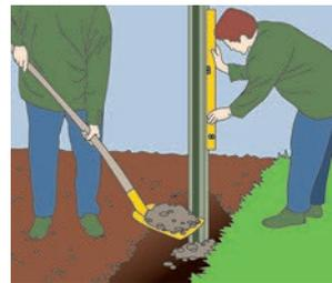
Die einzelnen Betonelemente werden immer waagrecht montiert. Der Anfangspfosten wird einbetoniert (Kies, Sand-Zement-Gemisch - Betongüte C16/20 - erdfeucht). Dabei besonders auf lotgenauem Ausrichten des Randpfostens achten.
