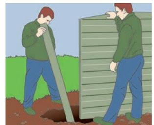
Danach wird der zweite Pfosten (Zwischenpfosten) zum Setzen weiterer Elemente passgenau angesetzt, lotgenau ausgerichtet und einbetoniert. Der Beton sollte für eine zusätzliche Unterstützung bis unter die Platten angefüllt werden.
