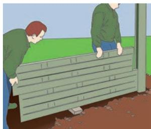
Im Anschluss daran erfolgt das passgenaue Einsetzen der Betonplatten bis zur Oberkante der Randpfosten in Waage. Dabei wiederum jeweils die einzelnen Platten verkeilen. Die Betonplatten sollten zur Unterstützung auf dem Fundament aufliegen, besonders wichtig bei doppelseitiger Montage.
