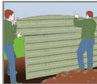
Nach Einsetzen der Platten wird der zweite Pfosten (Zwischenpfosten) zum Setzen weiterer Elemente passgenau an die Elemente angesetzt, lotgenau ausgerichtet und einbetoniert. Der Beton sollte für eine zusätzliche Unterstützung bis unter die Platten angefüllt werden.
