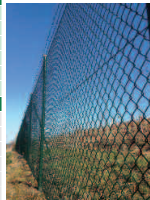
Drahtstärke 2,20 mm dick verzinkt und 2,80 mm Kunststoff ummantelt
